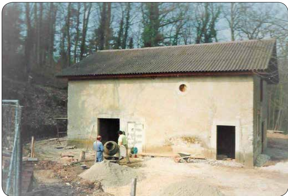
Le clos d'équarrissage au début des travaux en 1993
